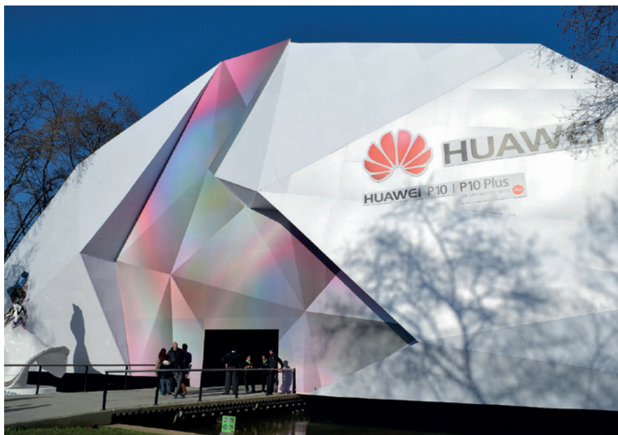
Stand de Huawei en el Mobile World Congress 2017 de PVC Integral Foam
